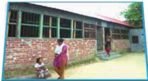
校舎3棟を建てました。
